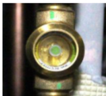
目には見えないわずかな気泡。フロンキーパーはこの時点で検知が可能。
